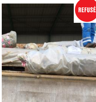
Tuyau fibrociment emballé non déchargeable car non mis sur palette
